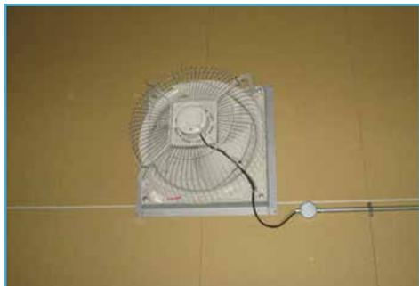
第一種換気設備を採用して室内の空気を強制的に入れ替えクリーンエリアからダーティーエリア、熱負荷の多い乾燥室に流れるように設計しました。
