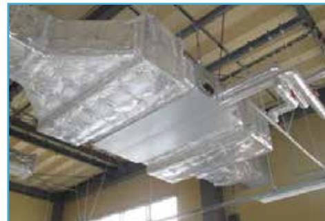
井戸水を熱源として冷却コイルに送り取入れた外気の温度を下げ湿り気のある風を送風ダクト、吹出ノズルを介して作業員に風が当たるように設計しました。(空調で消費する電力量を削減)
