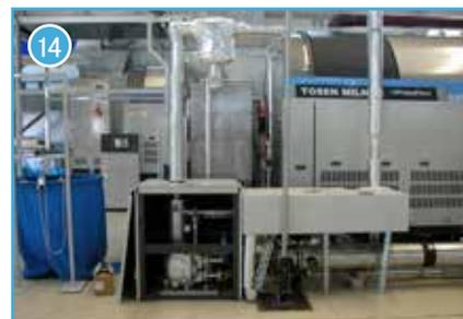
シーツ、包布仕上機からフラッシュ蒸気を効率よく回収し、連続洗濯機の昇温に活用しています。再利用することで、蒸気消費量の削減に努めています。
