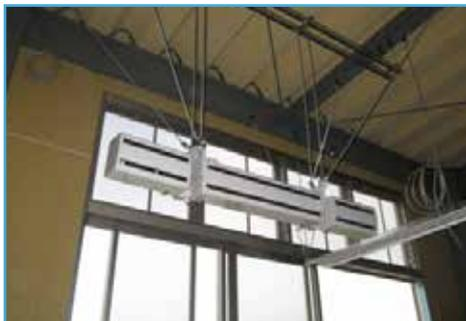
作業員周りに風の流れを作り体感的に涼しく感じるように計画しました。15m先まで風が流れるため快適な作業環境を生み出します。
