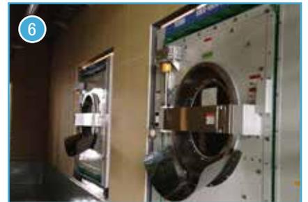
清潔・汚染区域を明確に区別するため、投入・排出口が別れている構造です。排出は自動でコンベアに排出され、乾燥機へ自動搬送/投入します。防水シーツ、布団類、枕の処理を行います。
